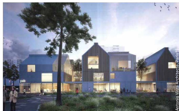
Le Pôle associatif, à l'angle de l'avenue des Pays-Bas et du boulevard de Yougoslavie (livraison au second semestre 2022)
