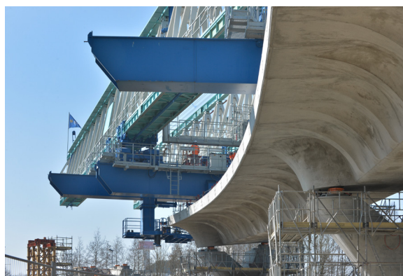
Avancement de la poutre - Mars 2017 - © Jean-Louis Aubert
