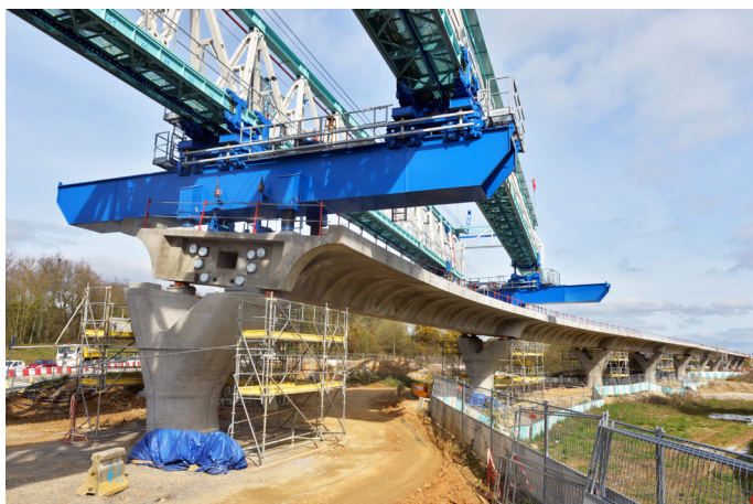
Déplacement de la poutre - Mars 2017 © Jean-Louis Aubert
